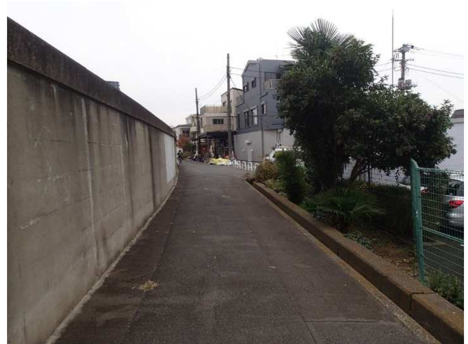
防潮堤の背後の状況（隅田川）
