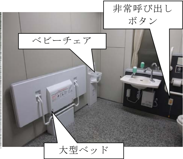
② トイレ内
