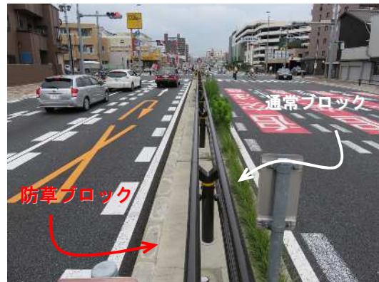
写真-1 H24年.08月完成 名古屋国道
