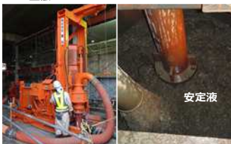
優位性が発揮できる安定液掘削工事
