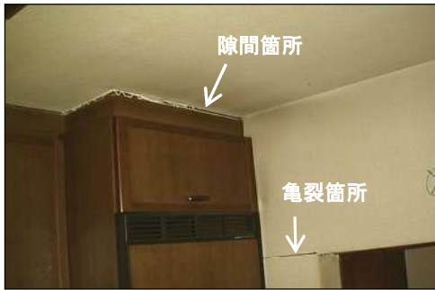
図-2. 実大建物の沈下実験
