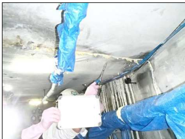
写真-1 漏水箇所の S T T G 工法施工状況写真
