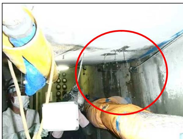
写真-1 漏水箇所の S T T G 工法施工状況写真
