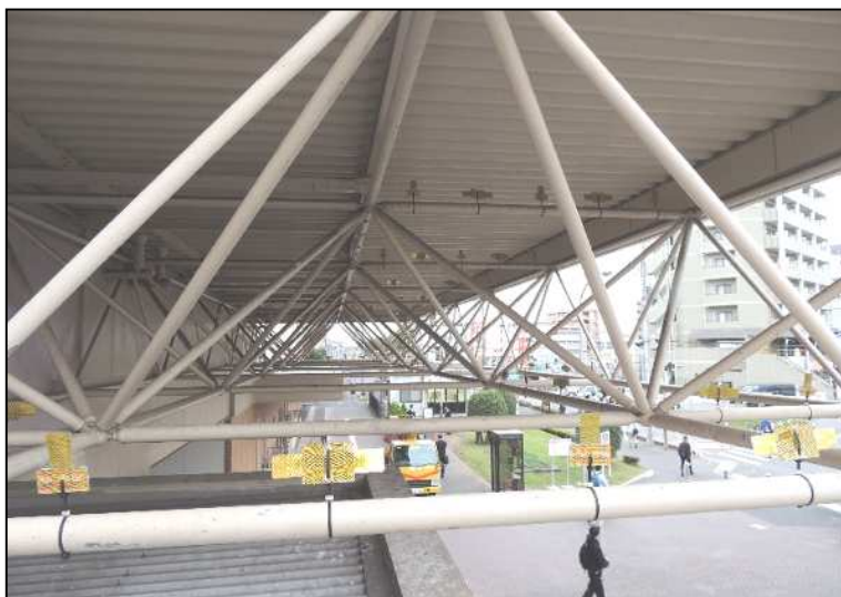
写真-1 「撃退ドットマン」の設置例
