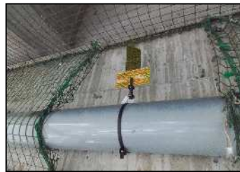
写真-10 施工直後
