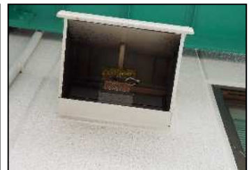
写真-14 換気口への対策例
