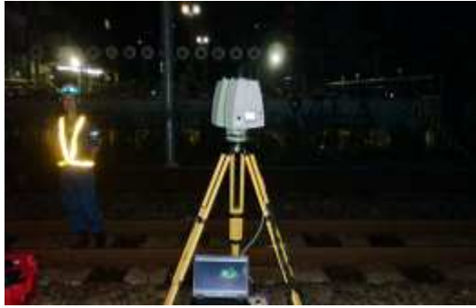
図-4 夜間における計測状況
