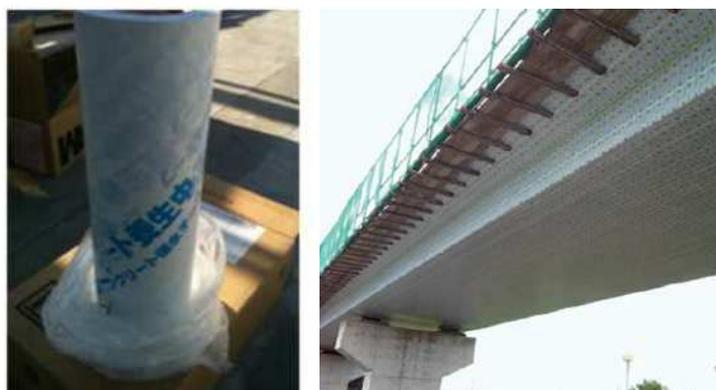
図-1 保水養生テープ製品外観と橋桁の施工状況
