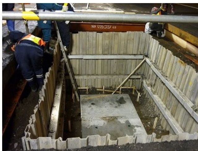
写真－1 水圧四面梁施工現場
