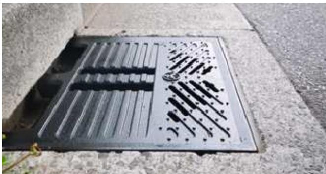
図1 60mm/hrの降雨でも越流しないGR-L
