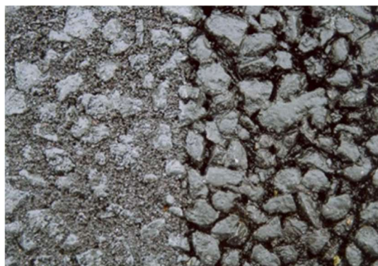
透水性レジンモルタル充填後 充填前
