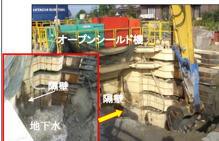
写真2. 切羽掘削状況
