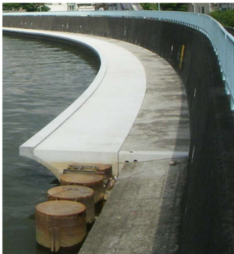
写真-1：中川護岸耐震補強の現況堤防上部工完成状況
