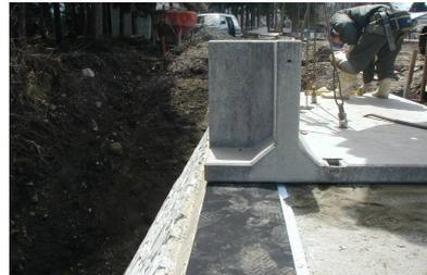
写真3 Gベース基礎背面からの施工状況
