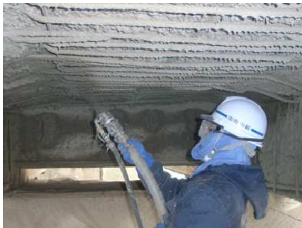
図1 N-SSI工法による吹付け断面修復
