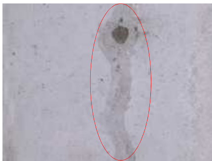
写真-3 自動式低圧注入工法の補修
