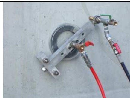
写真-2 真空吸着型注入機
