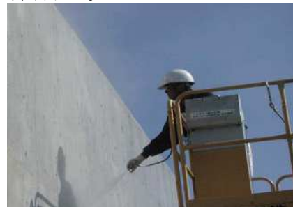
写真1 表面含浸工法塗布状況写真
