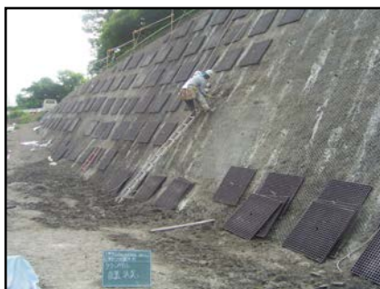
(写真1. グリーンパネル工法/施工例)
