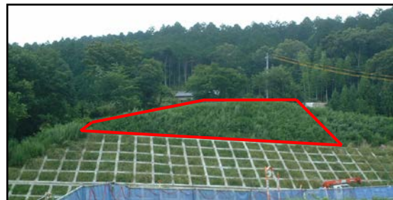
(写真4. グリーンパネル設置後2年経過)
