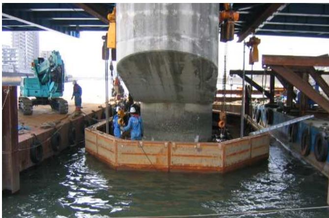
写真-1 鋼製パネル据え付け状況 (尾竹橋)
