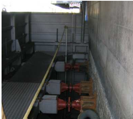
写真-3 支保工（足場兼用）
