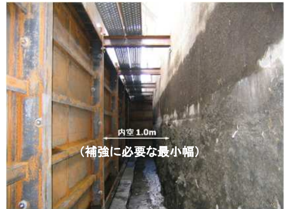
写真-5 仮締切内部 (補強に必要な最小幅)
