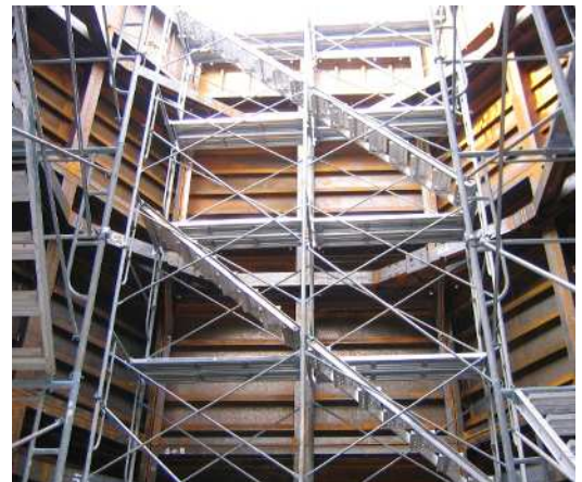
写真-2 鋼製パネルの内部 (尾竹橋)
