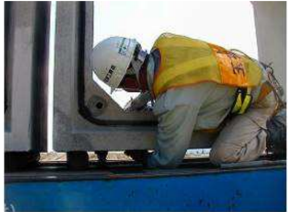
② 搬入車輛上でコンクリート二次製品にマルチレベル治具 I II の取付
