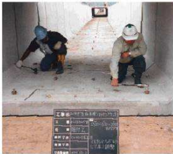
③ 市販のレンチ等を使用してマルチレベル治具 I を回す事により、上下の高さ調整作業を行う
