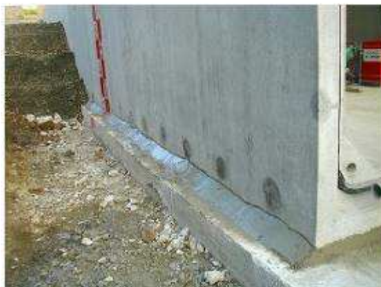
⑤ 高さ調整等により出来た、底版とコンクリート二次製品の空隙にドライモルタルにて間詰を行う
