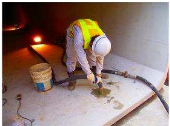
⑥ 圧入ポンプを利用してのグラウト充填作業生モルタル (1:2)
