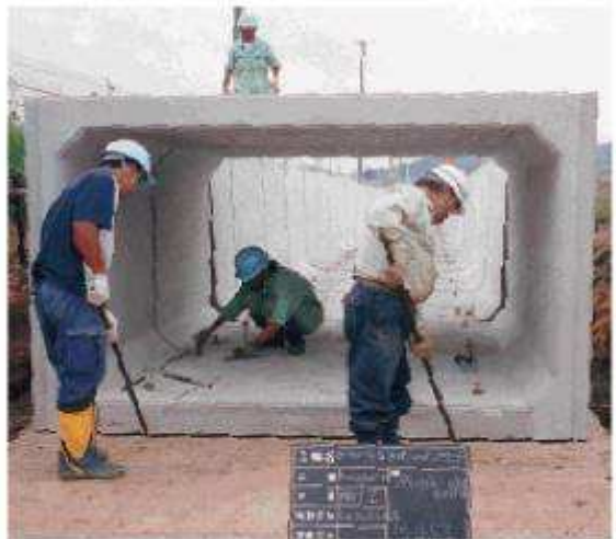
④ 市販の大型バール等を使用し、てこの原理を応用してスライドベース上を動かし、左右の位置調整作業を行う。
