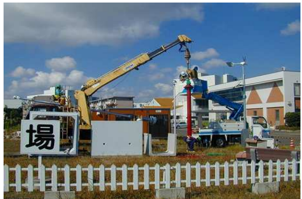
鋼管杭装着状況
