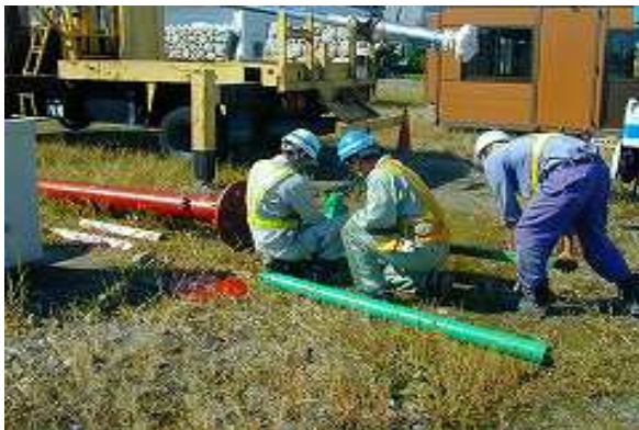
オーガー挿入状況
