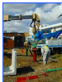
回転・圧入状況
