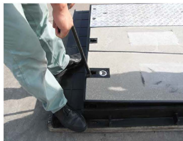
2. 開閉パールで持ち上げる
