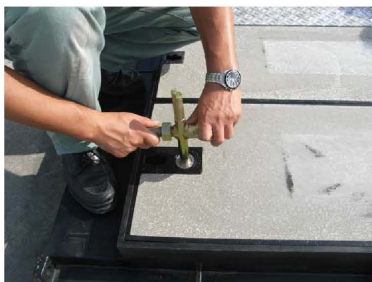
1. キャップを外しシリンダー錠を取る
