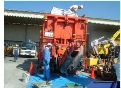
コンクリートの製造 (ジェットモビル車)
