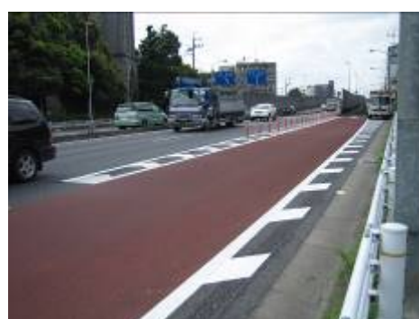
ポーラスニート施工事例 千葉県柏市
