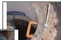
10) 固定ボルト設置工
