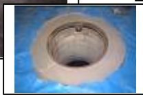
内部仕上がり状況
