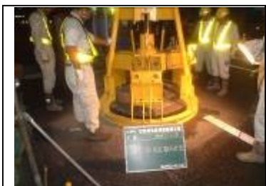
8) 開口蓋撤去工
