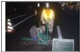
1) 舗装切断工
