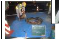
11) MRモルタル打設工
