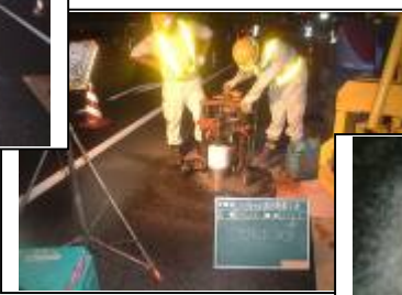
6) 開口蓋芯コアカッター工
