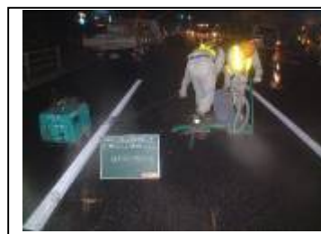
7) 舗装切断工
