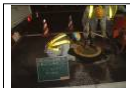
9) 人孔受枠据付工
