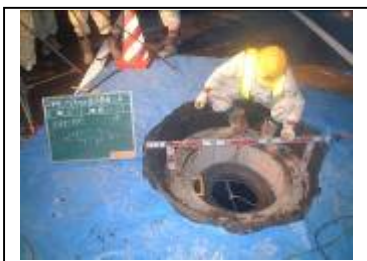
開口蓋撤去後
