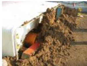
アプローチ掘進状況
