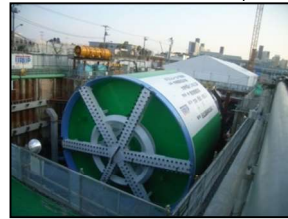
シールド機 発進前
