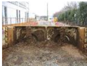
アプローチ掘進状況
