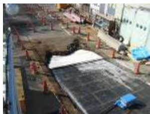
トンネル掘進状況
