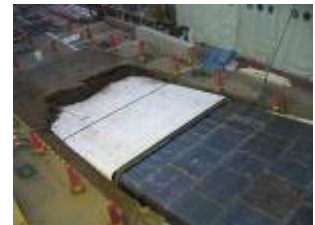
アプローチ→トンネル掘進状況
