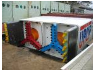
シールド発進状況
