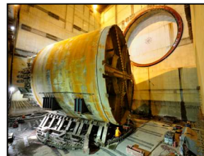
シールド機 回転状況
