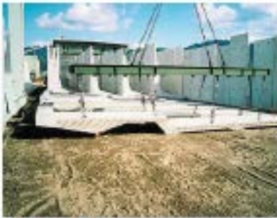
●スーパー床版製作
