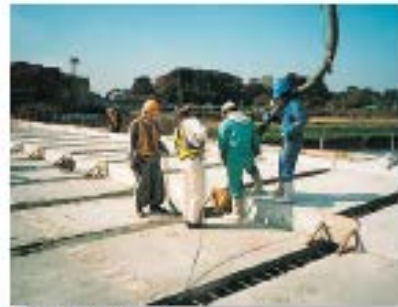
●継手部の配筋・打設
