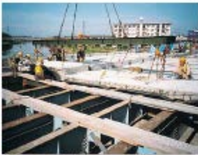
●スーパー床版の架設
