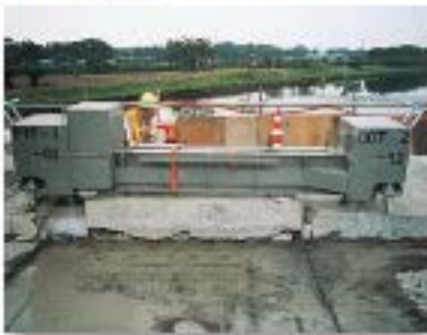
●既設床版の解体・撤去
