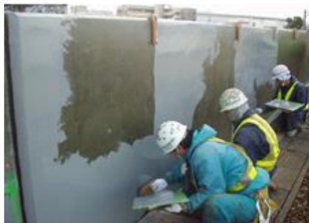
タフガードQ-Rの塗付状況
