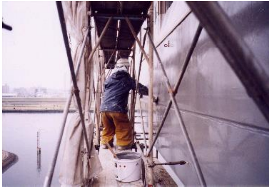
タフガードQ-R 塗付状況
