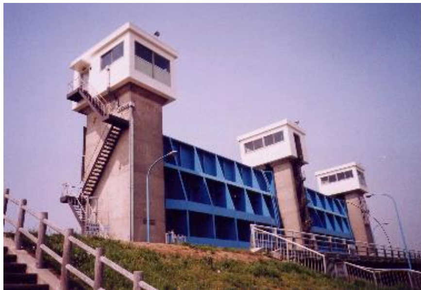
タフガードQ-R 工法施工完了状況（水門管理棟）
