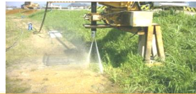
障害物削孔時の噴射状況
