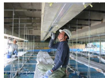
⑦プレート緊張材仕上げ塗装
