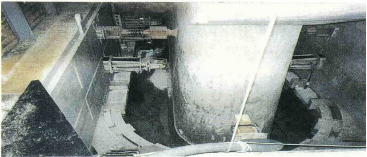
写真 上一色橋耐震補強工事
