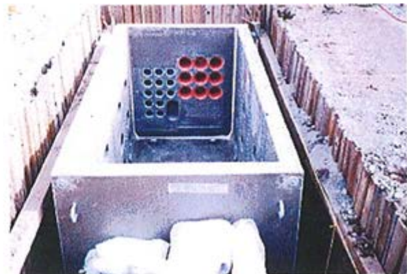
現場納入状況（設置後）
