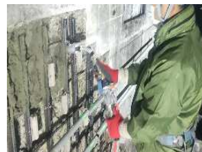
工程4 断面修復
