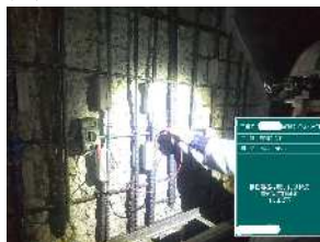
工程1 ガルバシールド設置
