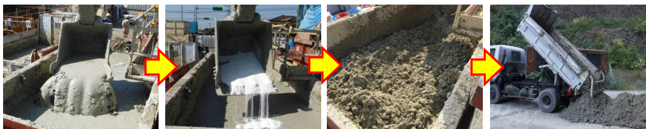
① 泥土をピットに投入 ② 本製品を泥土に添加 ③ バックホウで十分に混合 ④ ダンプで処理土を搬出
