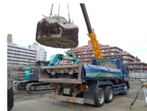
⑨余盛りコンクリート搬出
