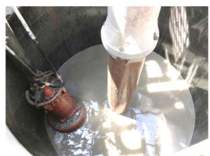
④トレー管挿入・ コンクリート打設状況
