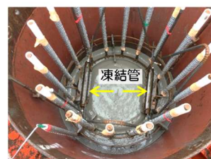
③鉄筋かご建込み状況
