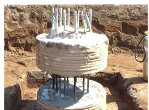
⑦余盛りコンクリート撤去
