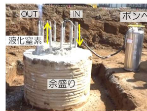
⑥液化窒素を用いた 静的破碎状況
