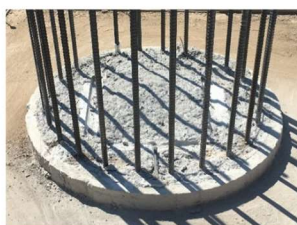
⑧余盛りコンクリート撤去完了
