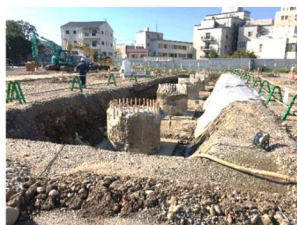
⑤根切り工事完了
