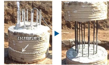
写真-1 凍結杭頭処理工法による杭頭処理
