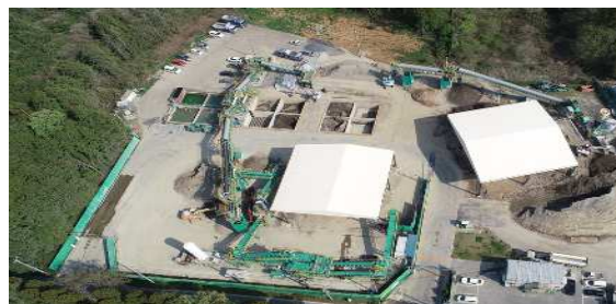
写真-1 JRC再生土プラント全景
