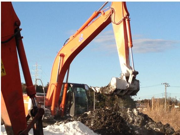
写真-1 施工例（バックホウ混合）
