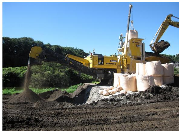
写真-2 施工例（自走式土質改良機混合）
