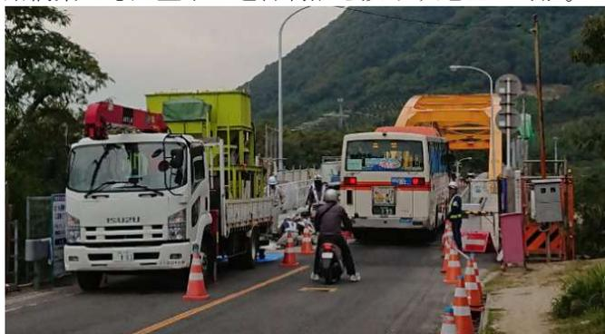
写真-5 幅員の小さい道路上で製造できる超速硬コンクリート
