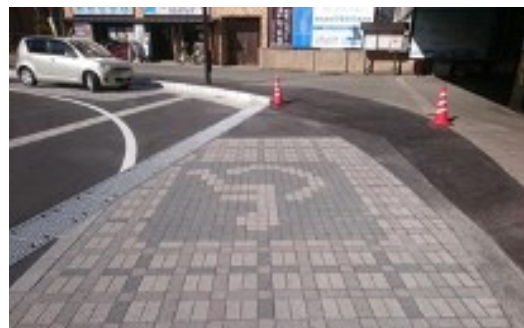
写真-8 路面標示の事例
