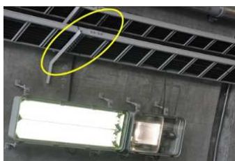
写真-3 配線取付工事例
