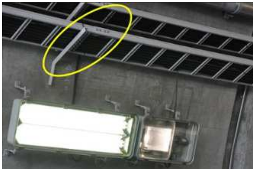
写真-2 使用例（トンネル内照明配線固定）
