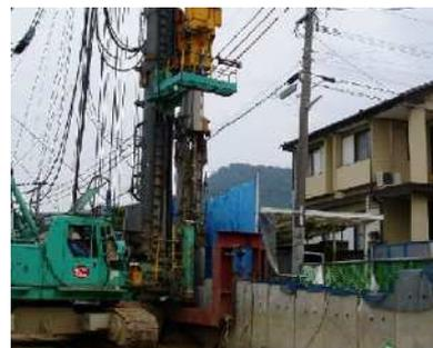
写真-2 中掘圧入工法による施工状況
