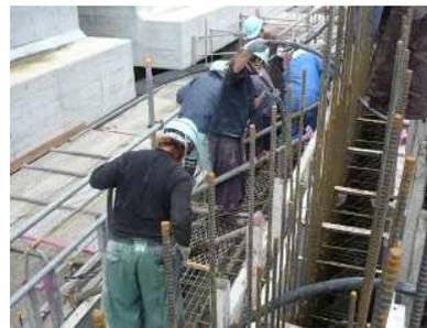
写真-3 バイブレータ作業
