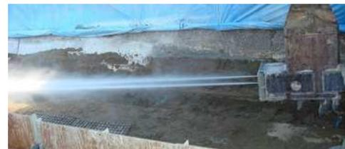
構造物を削孔せずに固化材スラリーを横方向に高圧で噴射してFTJ-FAN改良体を造成する。
