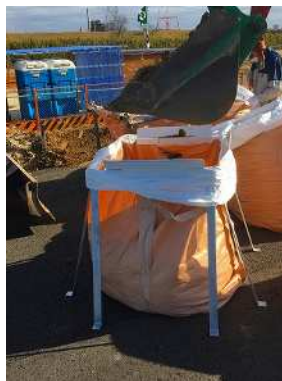
写真-3 トンサポ工法
