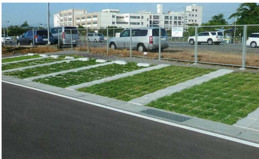
写真-1 コンタイブロックを使用した緑化駐車場施工例
