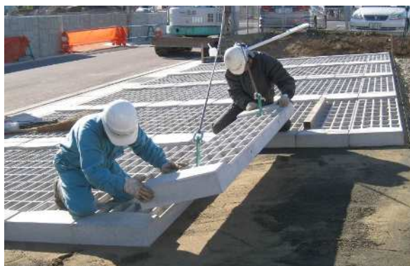
写真-2 コンタイブロック敷設状況
